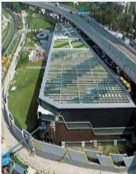
启德额外供冷系统- 海水电解氯化系统
