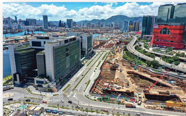
启德医院建筑工地A
