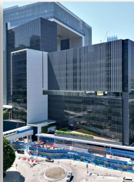
立法会综合大楼 扩建工程
