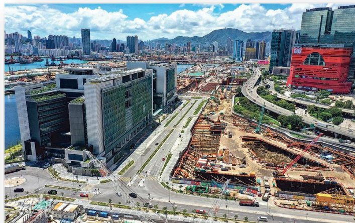
启德新急症医院建筑工地A
