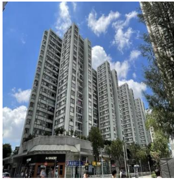
鲤景湾电动车基础设施
