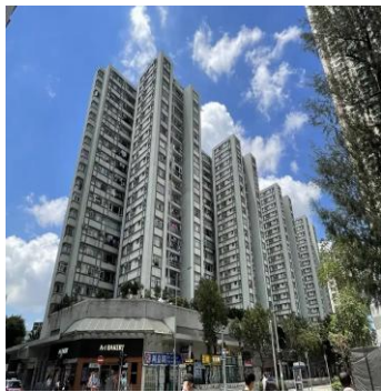
鲤景湾电动车基础设施
